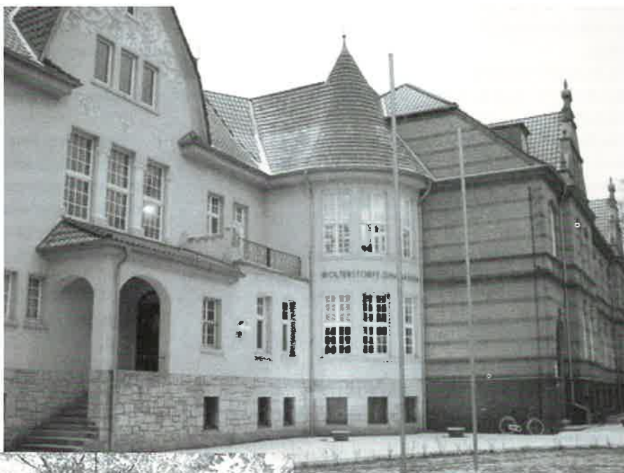
Haus 1 in der Bebelstrasse
