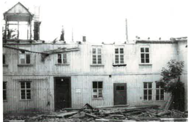
Abrissarbeiten am Internat
